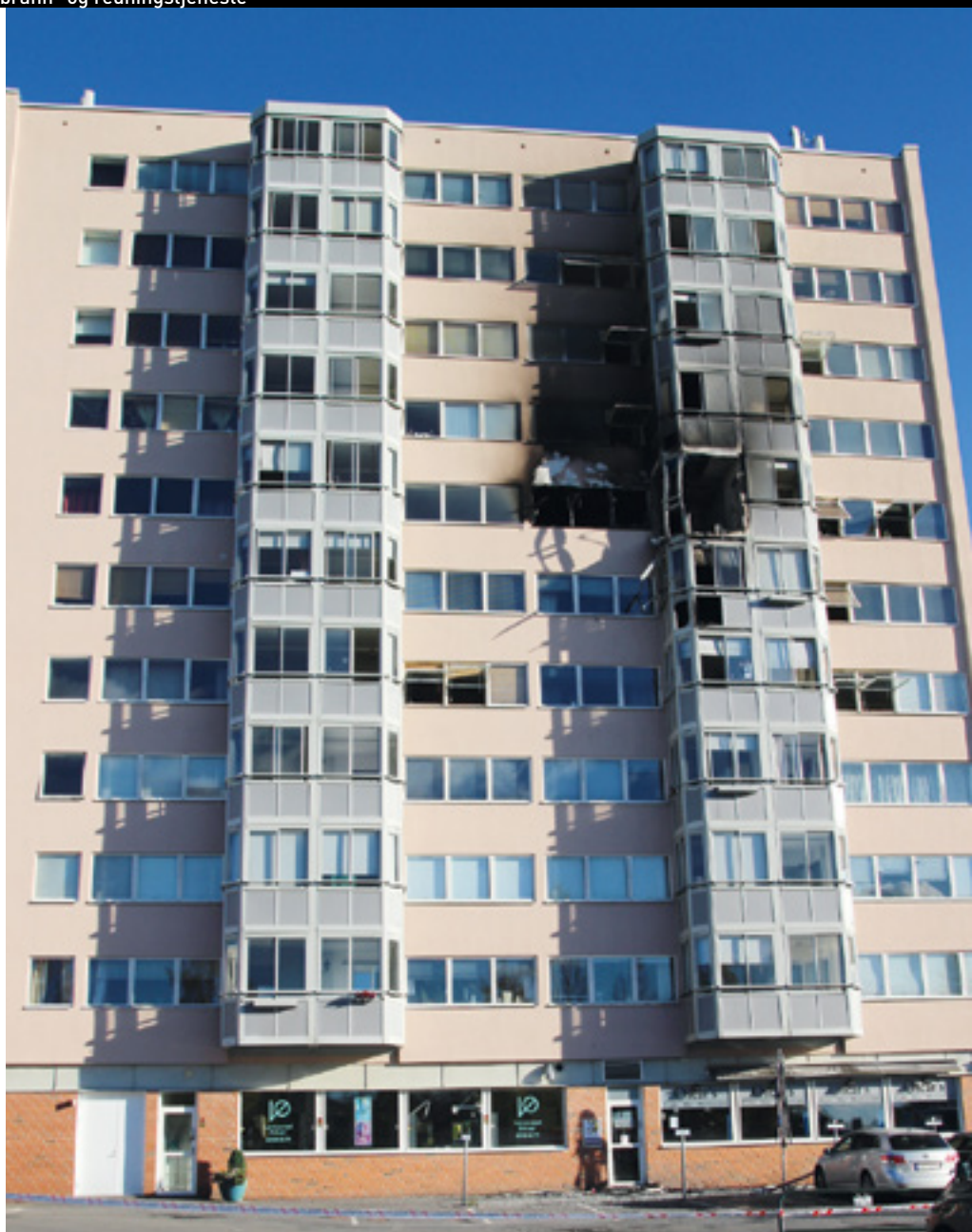
Brannen slikket opp etter fasaden, men brannspredningen til andre leiligheter begrenset seg til røykspredning via åpne vinduer.
