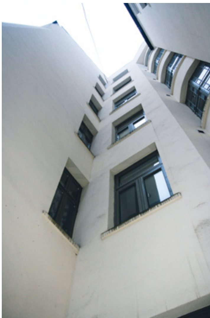
Brannen kan spre seg fra trappeoppgang til leilighet via vinduer i bakgården.
