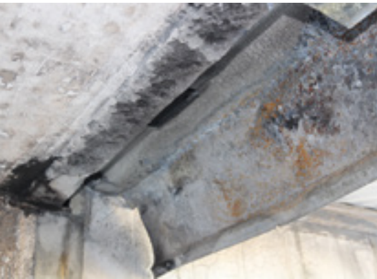
Utettheter i balkongtaket førte til at røyk spredte seg til balkongen over også.
