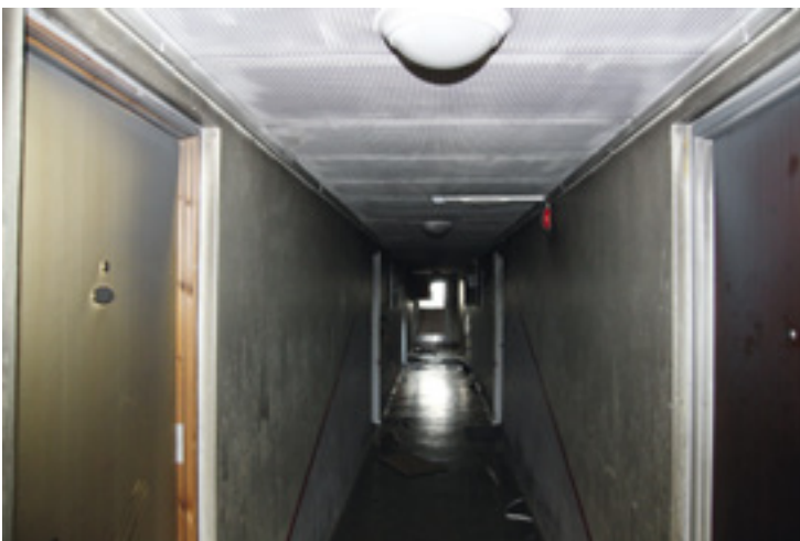
Korridoren har store brannskader.
